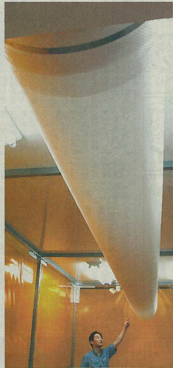
電石帽の静電気の原理を応用し、加工現場全体の空調機能を実現した「電石サニフィルター」(橿原市)
